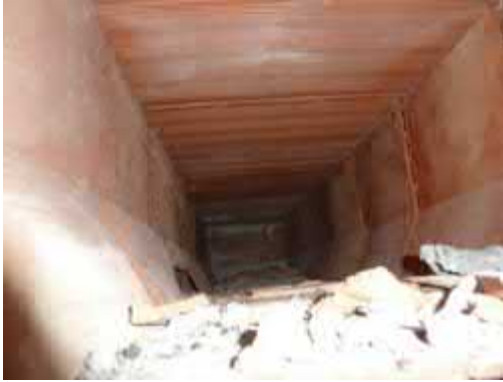
Analisi endoscopica interno del solaio
