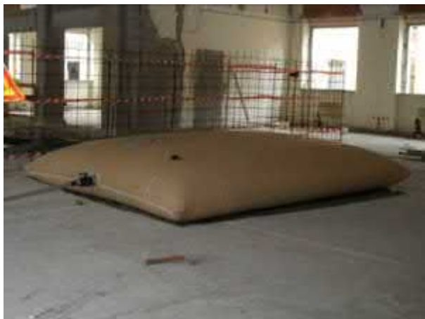
Serbatoio ad acqua per prova di carico
