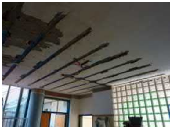
Interventi su travetti
